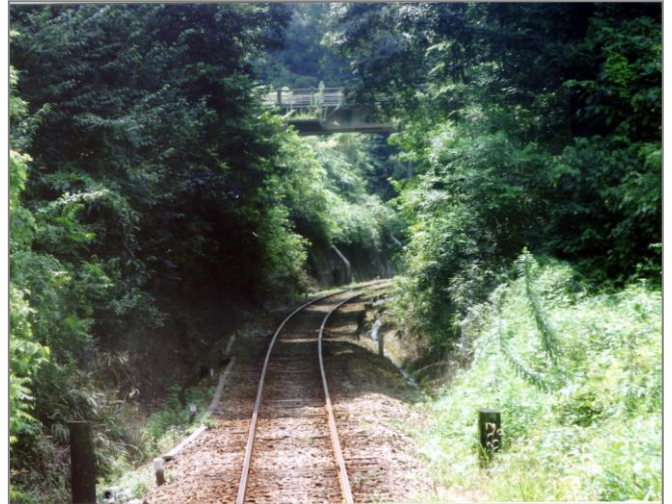
枝下～御船川間(跨線橋枝下方 22%の上り勾配)
