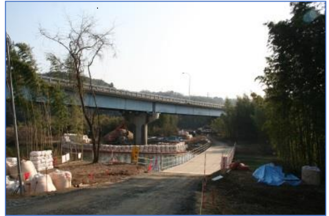
猿投グリーンロードの耐震補強工事…平成 19 年 10 月から中州まで栈橋を作る。
