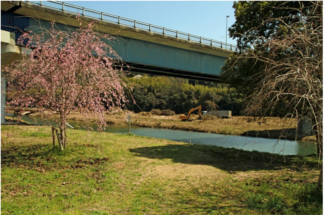
中州(枝下駅跡前)の草木伐採工事…令和3年3月23日
