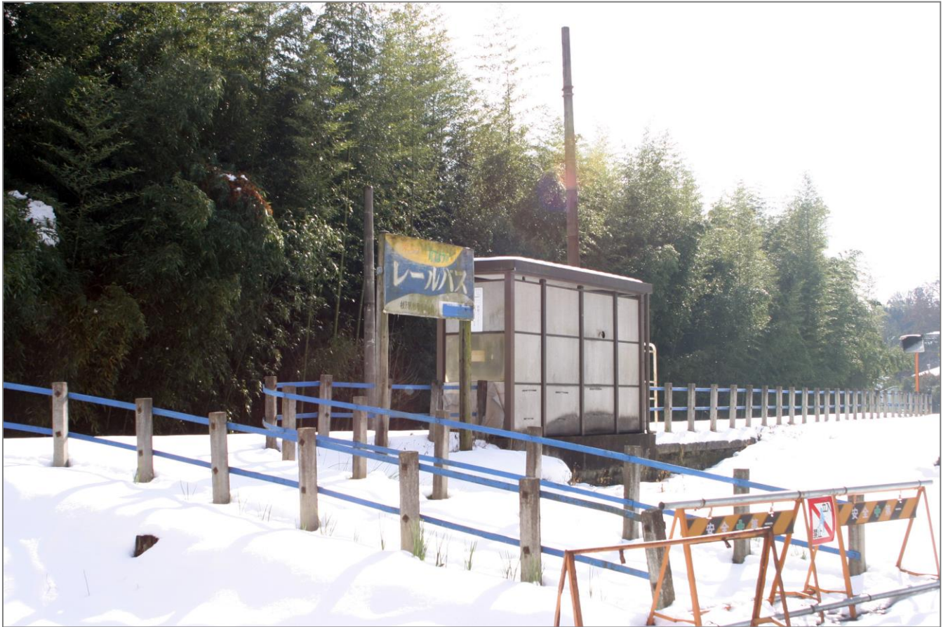
入口に工事用柵で通せん坊…平成 17 年 12 月 19 日
