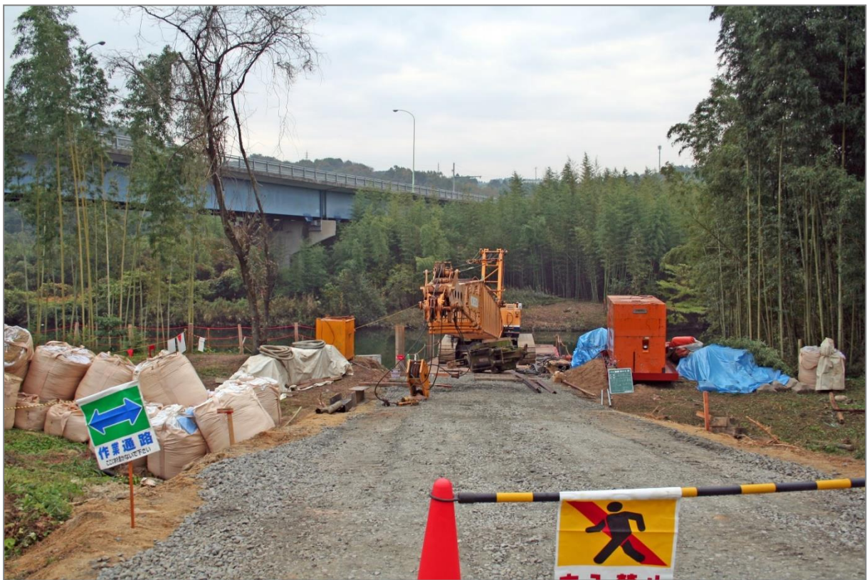
約 6 か月間、橋脚の耐震補強工事…平成 19 年 11 月 18 日
